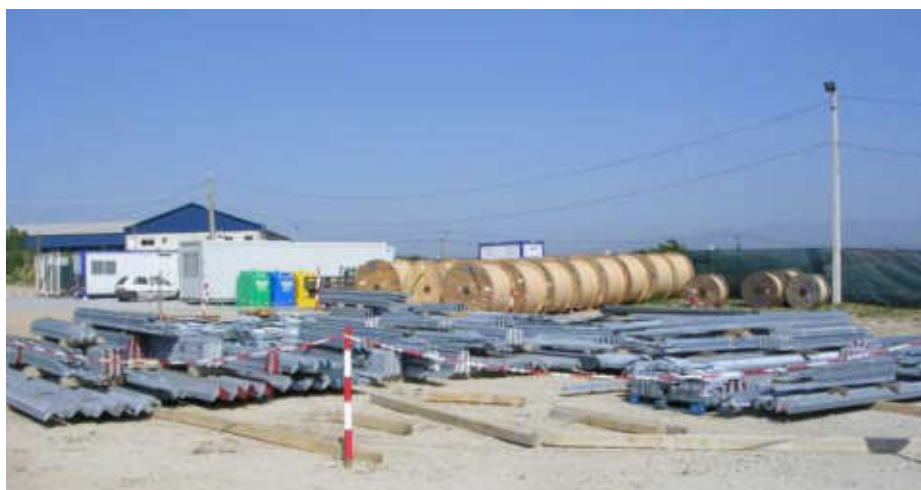
Fotografia 4.7 – Estaleiro de apoio à obra de construção de uma linha semelhante à agora em análise
