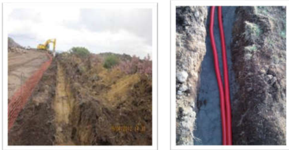
Fotografias 4.1 e 4.2 – Exemplo de valas para cabos
